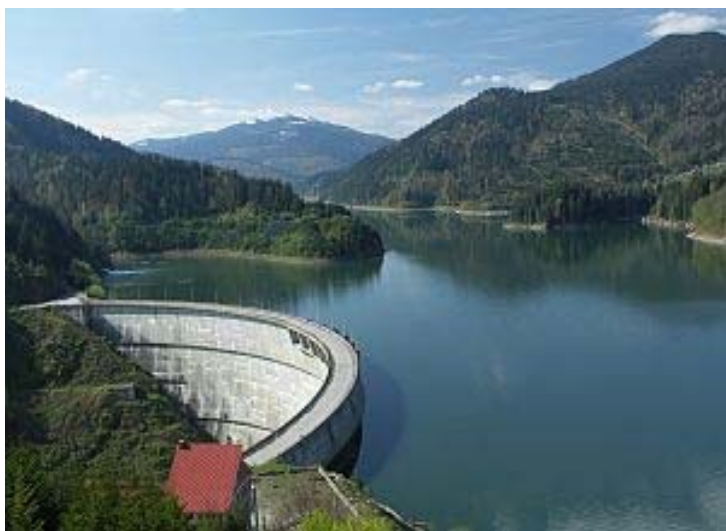
Fig. 148. Lacul și barajul Floroiu de pe Valea Drăganului.
