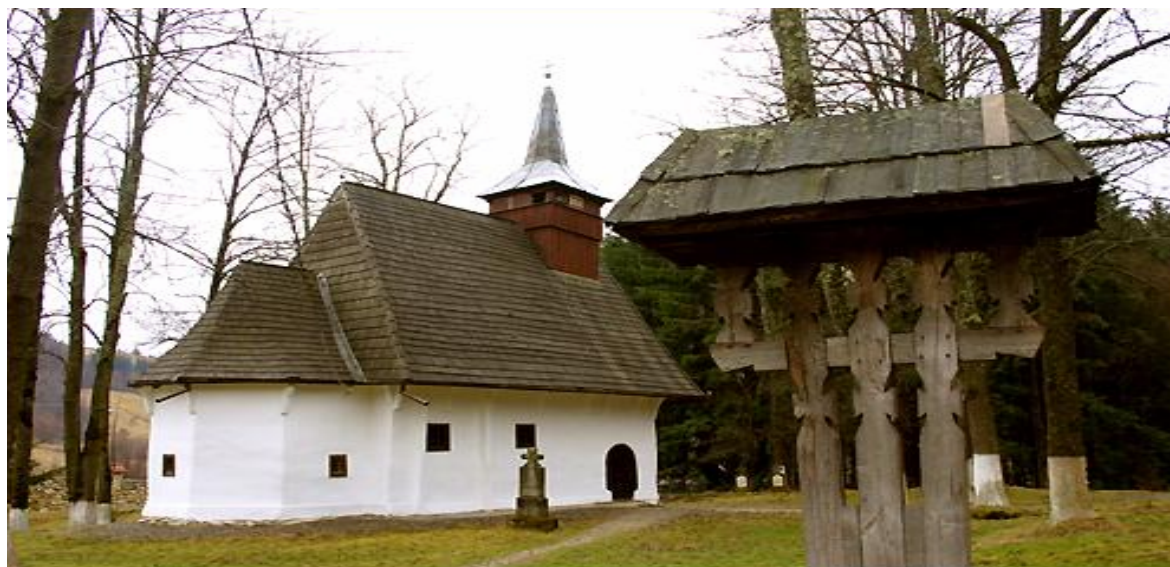
Fig. 158. Biserica de lemn din incinta Mănăstirii Lupșa construită la 1421.
