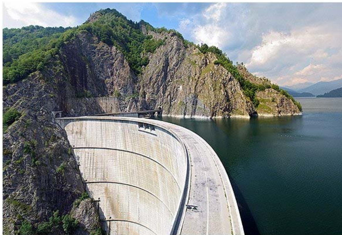
Fig. 93. Barajul și lacul de acumulare hidroenergetic Vidraru.
