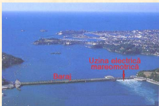
Centrala mareomotrică de pe estuarul râului La Rance, Franța (după www.pteratunes.org.uk ).
