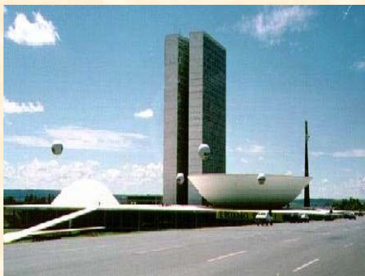
Clădirea Senatului din Brasilia – este cea mai înaltă și solitară clădire din capitala Braziliei, la periferia acesteia dezvoltându-se pădurea ecuatorială (după www.raphaelk.co.uk ).
