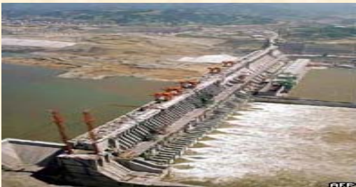
Barajul hidroenergetic de pe fluviul Yangtze, China. Lacul de acumulare care se va forma în spatele barajului va avea suprafața de 1100 km 2 , o capacitate utilă de stocare de 40 mld. m 3 de apă, o lungime de 600 km, o adâncime lângă baraj de 175 m, iar costul de execuție se estimează a fi de 29 mld. $ S.U.A. (după news.bbc.co.uk).
