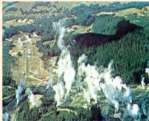
Apele geotermale folosite de centrala Wairakei, Noua Zeelandă, ajută la producerea a 10 % din energia electrică a acestei țări (după revista Arborele Lumii , 2002).
