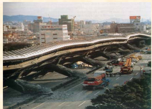
Efectele devastatoare ale cutremurelor din Japonia. O autostradă suspendată din Kobe a fost distrusă în totalitate cu ocazia cutremului din ianuarie 1995 soladată cu peste 5 000 de morți (după R. Knafou, 1995).
