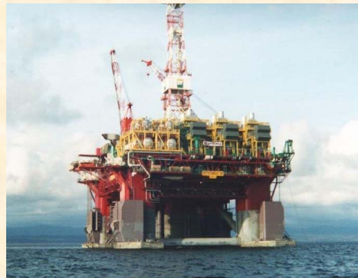
Platformă marină de exploatare a petrolului în Marea Nordului (după R. Knafo, 1995).
