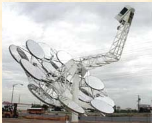
Stație de captare a energiei solare pe bază de celule fotoelectrice, capabilă să se orienteze automat după mișcarea Soarelui (după www.spaceconstruction.com ).
