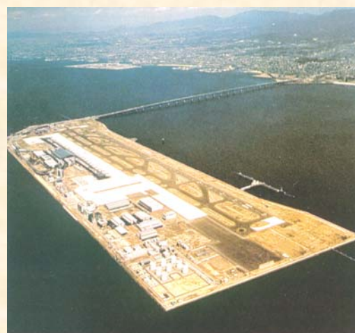
Aeroportul internațional din Kansai, Japonia, construit pe o insulă artificială în Marea Japoniei. Construcția sa a fost determinată de lipsa terenului plan pe uscat și densitatea mare a construcțiilor în cadrul orașului (după Y. Carlot, 1995).
