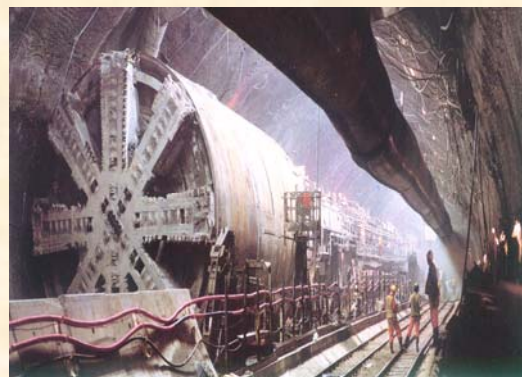
Lucrările de construcție la Eurotunel pe sub Canalul Mânecii între Franța și Marea Britanie. Lucrările la acest tunel au început în 1987 și au durat 7 ani. Are o lungime de 38 km între localitățile Sangatte și Shakespeare Cliff (după revista Arborele Lumii , 2002).
