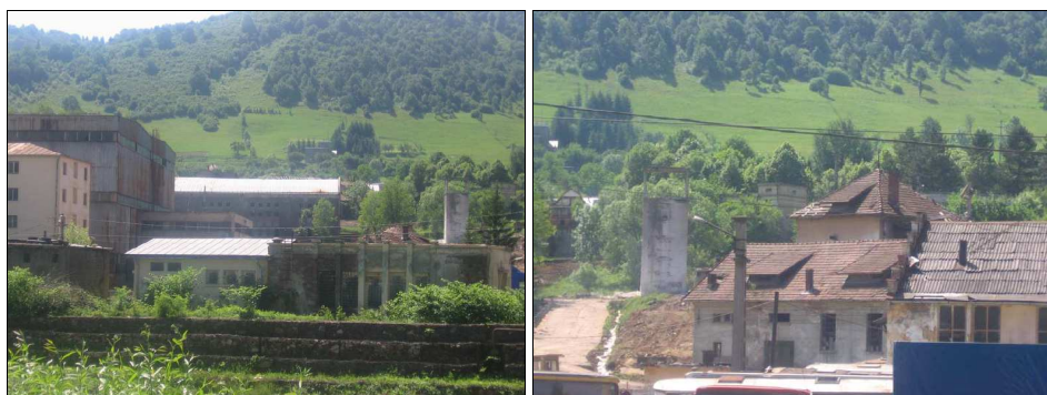
Fig. 101. Uzina de preparare a E.M. Baia de Arieș (Foto: Camelia Costan, iunie 2009)
