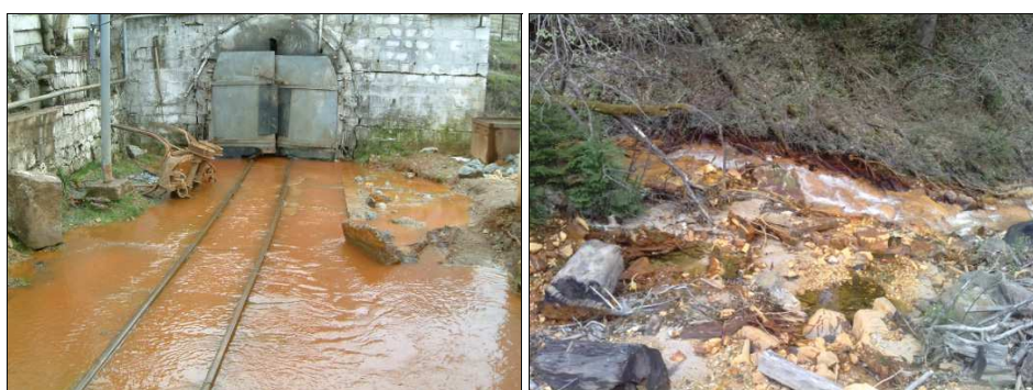
Fig. 118. Ape acide din Roșia Montană (Foto: Panoramio, ID: 41262866 27 , ID: 41263051 28 ) și Bucium (Foto: Constantin Veronica, 2010)
